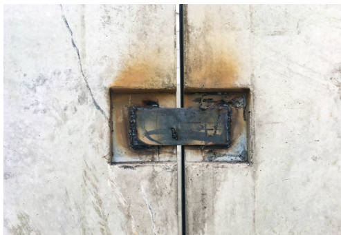
Färdig koppling med ingjutna svetsplåtar
