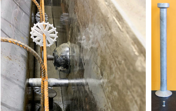
Kulankare som används tillsammans med gummiursparing
